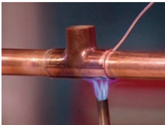
شکل ۱-۴- یک نمونه لحیم کاری سخت استاندارد
