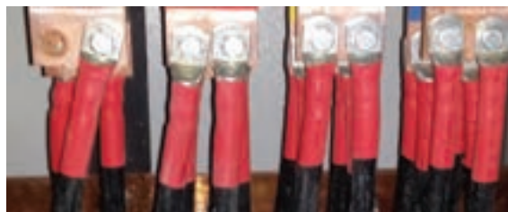
شکل ۱۷- عایق حرارتی کابلشو
