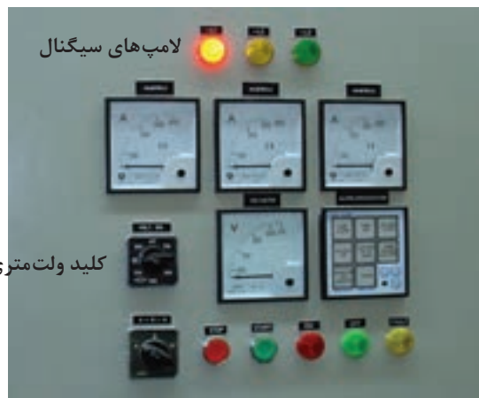
شکل ۷۳- کلید ولت متری و لامپ سیگنال معمولی
