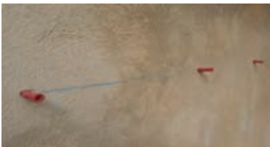
شکل ۳۵- نصب رول پلاک‌ها
