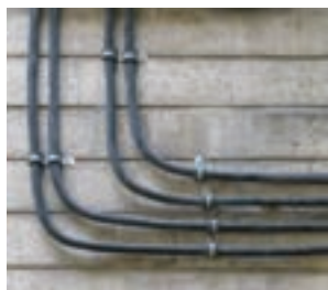
شکل ۲۱- خمش کابل
