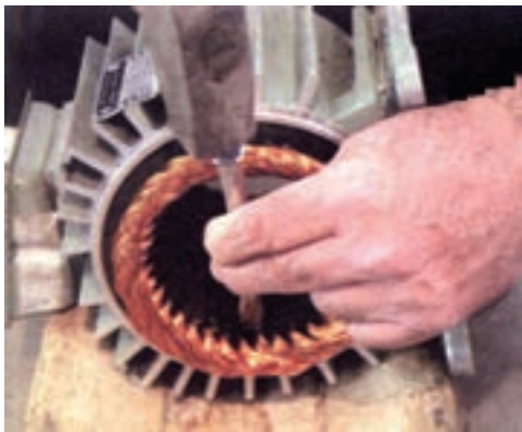
شکل ۲۱- بریدن سیم‌ها توسط قلم
