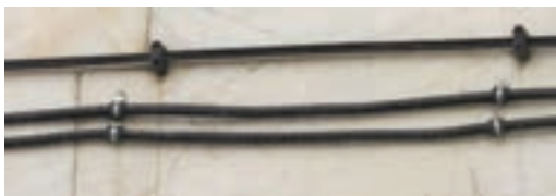
شکل ۲۷ - فاصله بین بست‌ها
