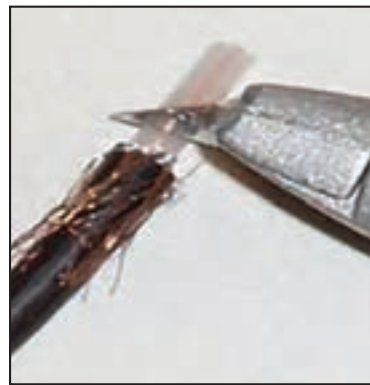
۵- اندازه مفتول مسی نباید بیش از یک و نیم سانتی متر باشد و قسمت بافته را نیز روی پوسته خارجی پخش کنید.
