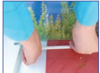
ت - نصب تجهیزات
