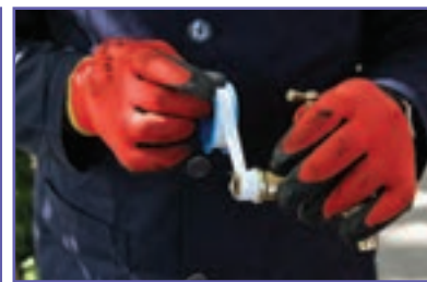
پ- پیچیدن نوار تفلون روی شیر نو
