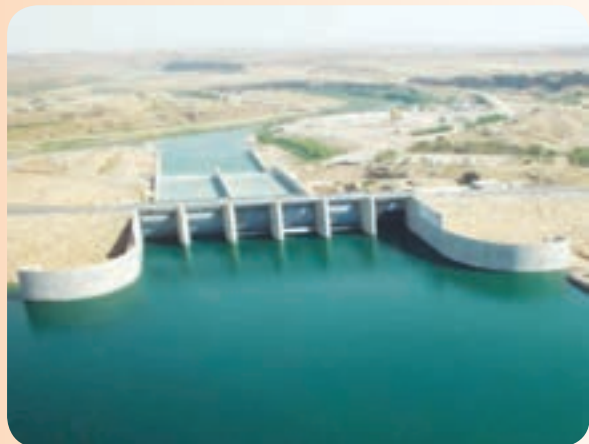
سد کرخه، بزرگ‌ترین سد خاکی - رسی خاورمیانه
