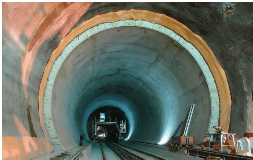
ب) پوشش داخلی تونل به وسیله قطعات بتن
