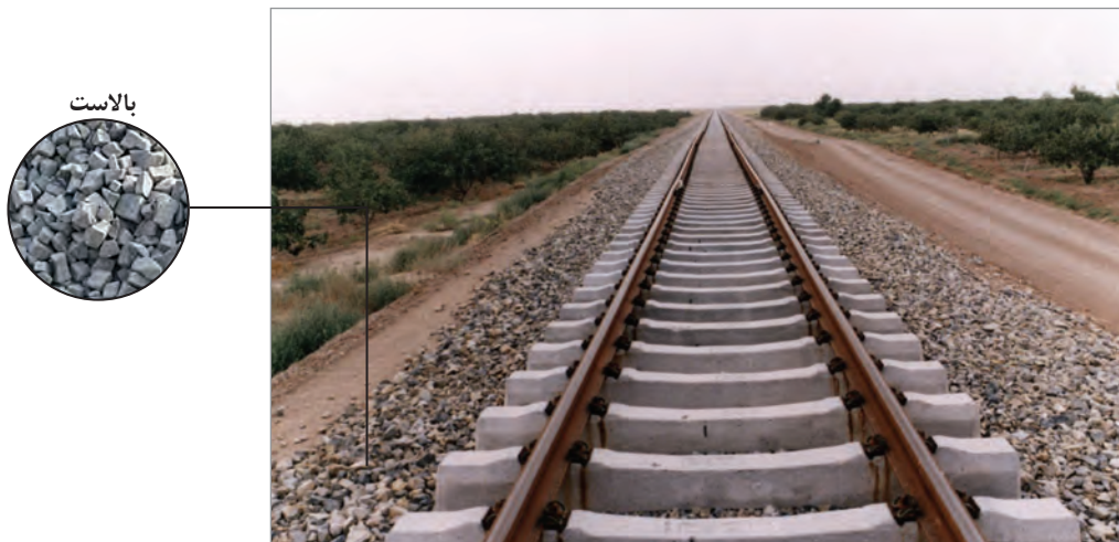
شکل ۴-۱۱- بالاست در زیرسازی جاده ریلی
