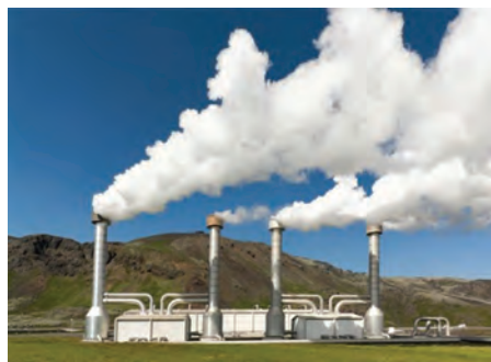
شکل ۱۱-۶- نیروگاه زمین گرمایی مشکین شهر - اردبیل
