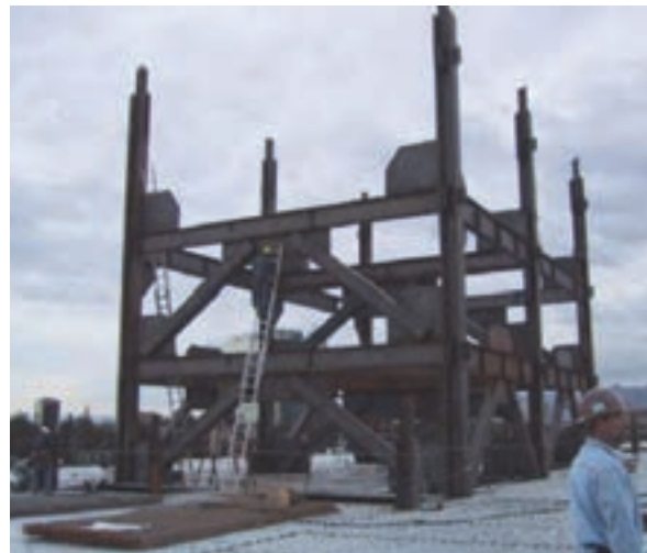
شکل ۳-۸ - تصویر یک سازه‌ی فلزی
