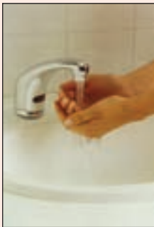
شکل ۱۳-۷- شیر اتوماتیک چشمی ▲
