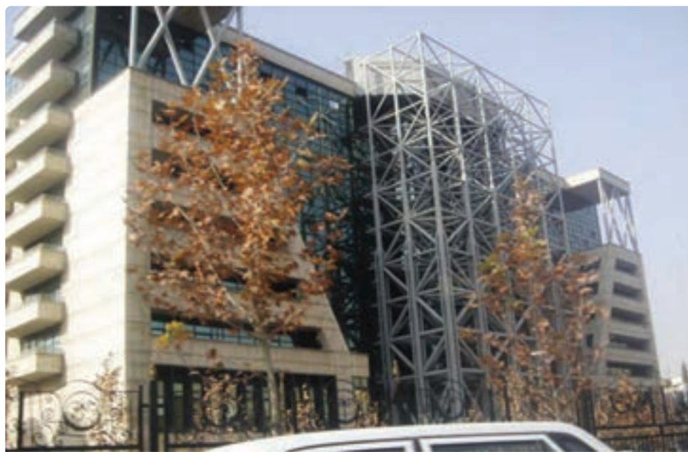
شکل ۱۲-۲- ساخت و سازهای جدید شهری
