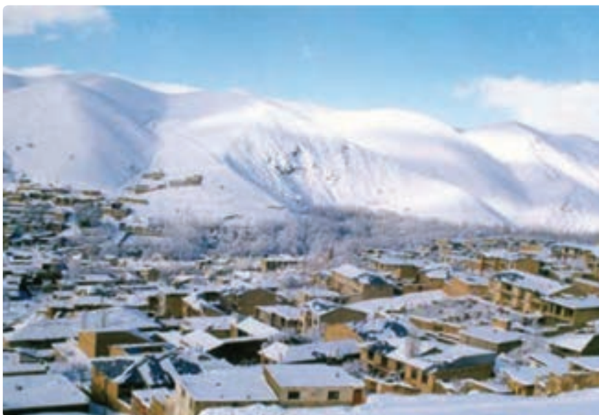
شکل ۱۹-۱- نقش آب و هوا در شکل‌گیری سکونتگاه‌ها
