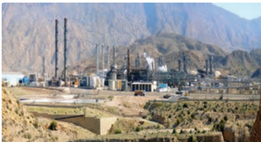
شکل ۱۲-۱۳- تأسیسات گازی پارس جنوبی
