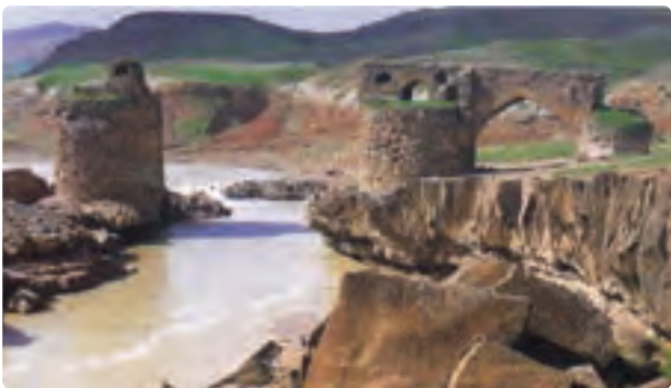
شکل ۲۹-۵- پل گاومیشان دره شهر
