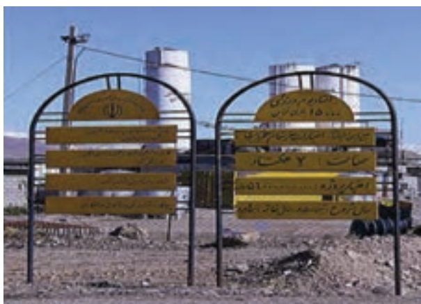
شکل ۱۰-۶- ورزشگاه ۱۵۰۰۰ نفری قزوین در حال ساخت
