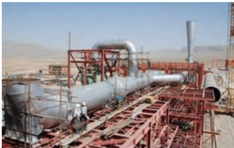
تصویر ۱-۱۵- کارخانه درحال احداث فولاد چهارمحال
