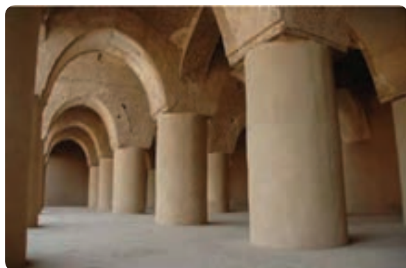
شکل ۱۴-۵- مسجد تاریخانه در شهر دامغان
