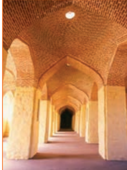
شکل ۲۳-۴- نمایی از داخل مسجد جامع ارومیه
