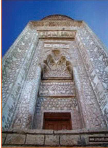
شکل ۲۴-۴- نمایی از سه گنبد ارومیه
