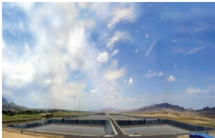
شکل ۱۶-۵- تصفیه‌خانه فاضلاب شهر بیرجند
