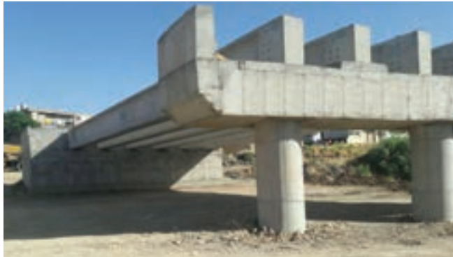
شکل ۱۲- تصویر پل نیمه تمام
