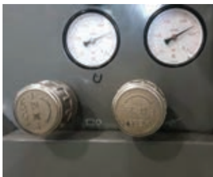
شکل ۴۲- شیر تنظیم مکش (شیر سمت چپ)
