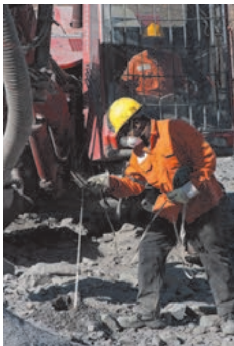
اندازه‌گیری عمق چال حفاری شده به وسیله متر وزنه‌دار
