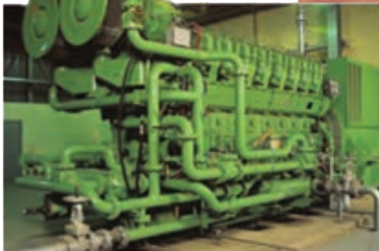
موتور ژنراتور یک نیروگاه برق اضطراری معدن
