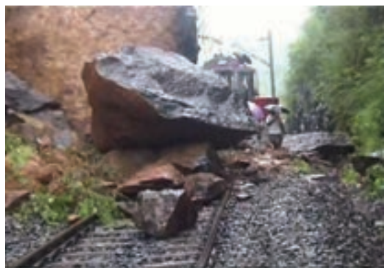
شکل ۴-۷- تخریب ریل خط آهن معدنی در اثر ریزش
