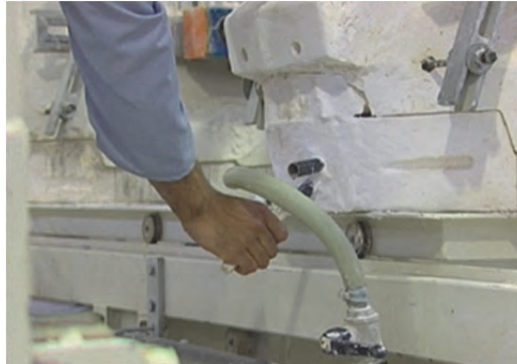
شکل ۳۵- باز کردن لوله‌ها جهت تخلیه دوغاب اضافی
