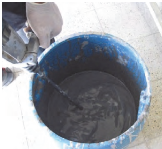
شکل ۱۸- هم زدن دوغاب قبل از ریخته‌گری
