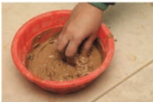
شکل ۱۰- تهیه گل یکنواخت با دوغاب
