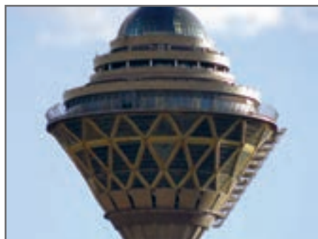
شکل ۱- سازه فلزی برج میلاد تهران
