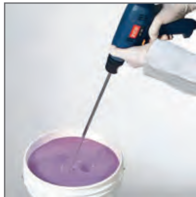
۱ مخلوط کردن لعاب با استفاده از همزن
