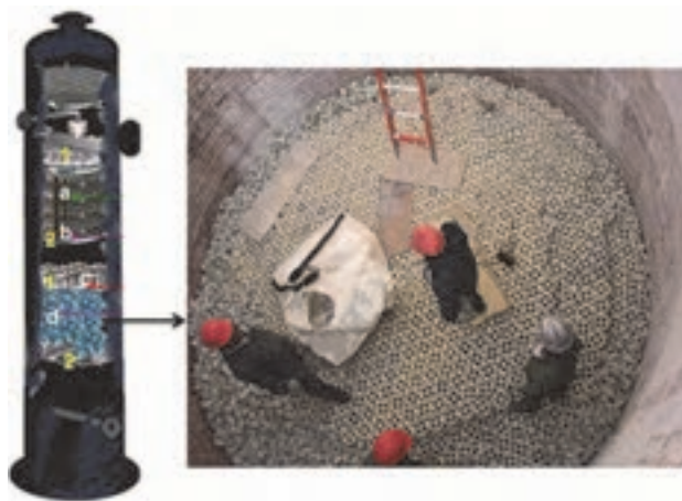
شکل ۷- داخل یک برج در حال چیدن پکینگ‌های سرامیکی
