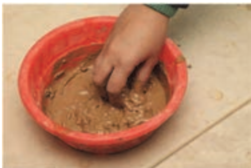
شکل ۱۰- تهیهٔ گل یکنواخت با دوغاب
