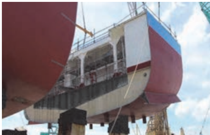
شکل ۸- اتصال بلوک‌های کشتی
