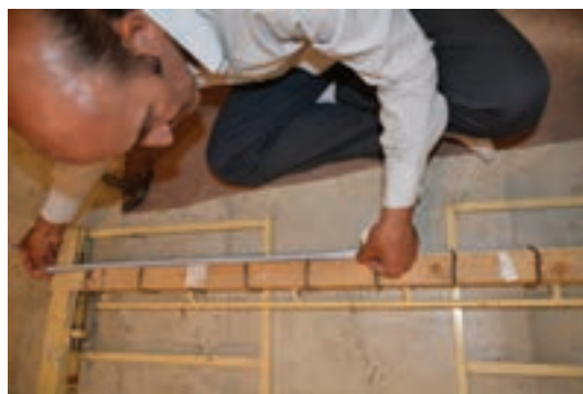
شکل ۱۸-۵ - نشانه گذاری بر روی چوب پایین کشی
