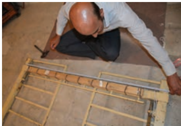
شکل ۱۶-۵ - نصب چوب پایین کشی پشت زیردار
