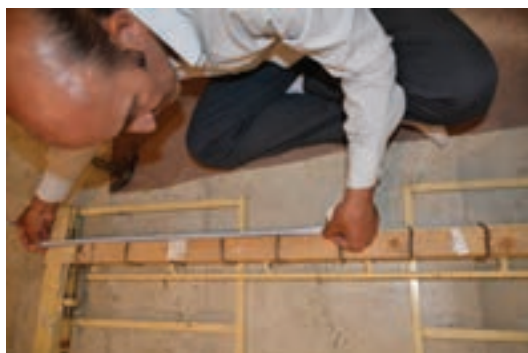
شکل ۱۸-۵ - نشانه‌گذاری بر روی چوب پایین‌کشی
