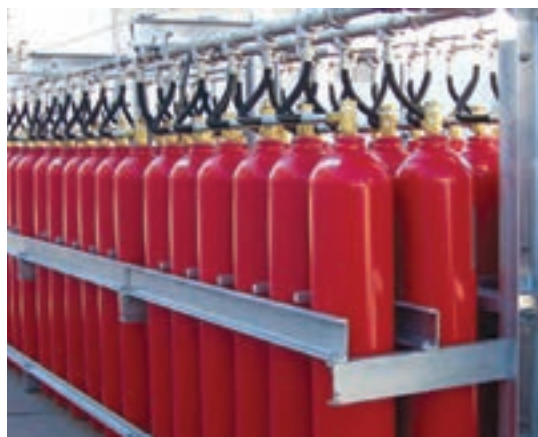
شکل ۳۸- سامانه اطفای حریق CO 2
