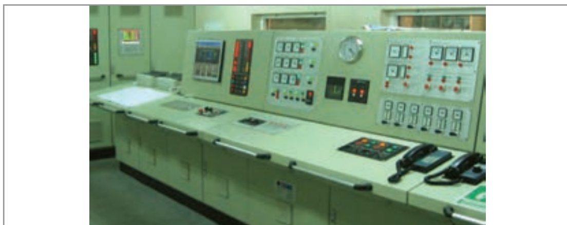
شکل ۴۰ - سامانه هشدار اتاق کنترل موتورخانه
