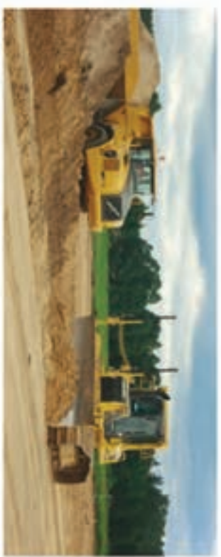
بلدوزر و کامیون در حال تسطیح محوطه
