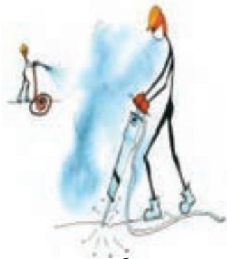
استفاده از اسپری آب جهت کاهش گردوغبار
