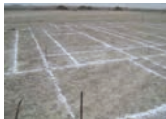
زمین گچ‌ریزی شده
