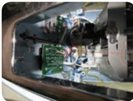
شکل ۵۷- محل اتصال قسمت‌های فلزی
