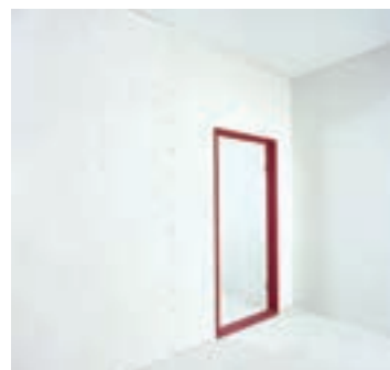
شکل ۱۴۲-۱- پیچ زنی پانل در حاشیه دور چهارچوب
