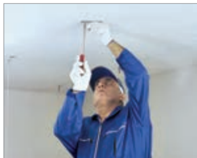
شکل ۳-۱۱۶ اتصال قطعه HT ۹۰ به سقف اصلی شکل ۳-۱۱۷
