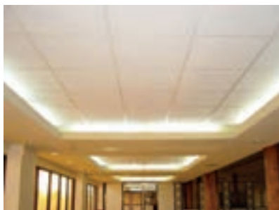
شکل ۱۱۰-۳- اجرای کامل سقف مشبک به روش قرینه‌سازی
