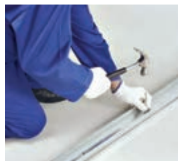
شکل ۴۲-۱- اتصال رانر به کف با رول پلاک
