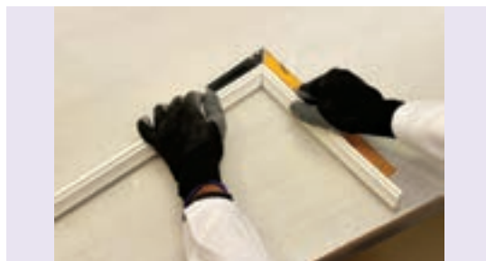
شکل ۲۲۹-۱ کنترل گونیا بودن قطعات قبل از نصب
