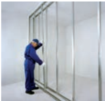
شکل ۹۶-۱. شاقولی کردن ردیف اول استادها
