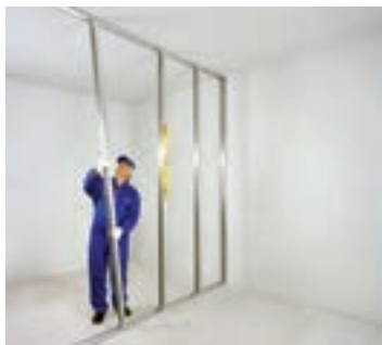
شکل ۸۳-۱- اجرای ردیف اول استاداها (به صورت شاقولی)
