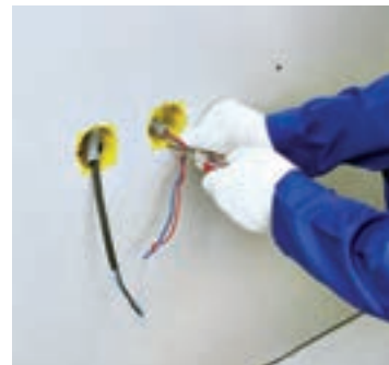
شکل ۱۷۶-۱ گیره‌ها توسط پیچ گوشتی جمع می‌شوند.
