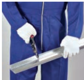
شکل ۱۱۳- برش انتهای رانرهای کف شکل ۱۱۴- نصب رانر کف شکل ۱۱۵- خم کردن انتهای رانر کف
