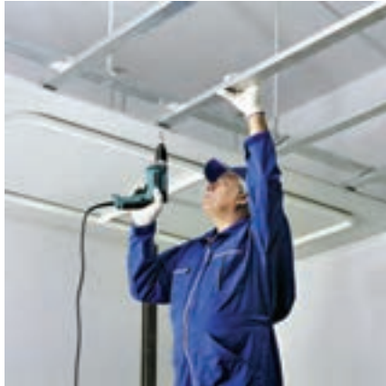
شکل ۳-۶۷ اتصال پانل به زیرسازی توسط پیچ
