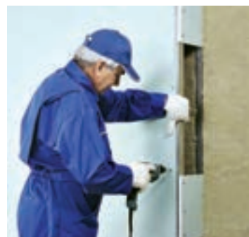
شکل ۱۰۰-۱- اجرای پانل‌ها در طرف دیگر دیوار
