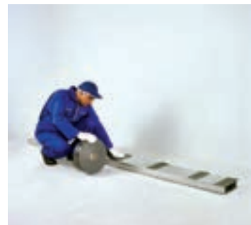
شکل ۸۱-۱- اجرای نوار عایق بر روی استاداها
