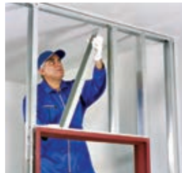
شکل ۱۳۱- استقرار استادهای کتیبه
