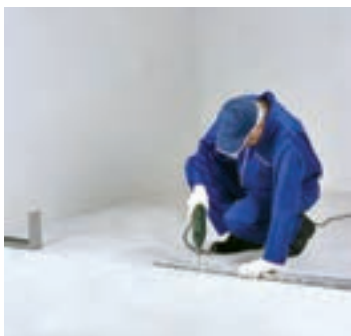
شکل ۱۱۳- برش انتهای رانرهای کف شکل ۱۱۴- نصب رانر کف شکل ۱۱۵- خم کردن انتهای رانر کف
