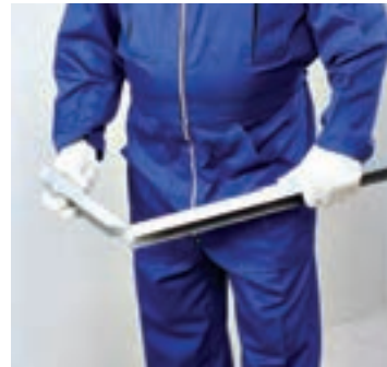
شکل ۱۲۸- خم کردن انتهای رانر نعل درگاه
