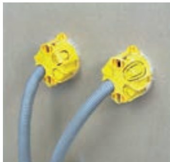
شکل ۱۷۷-۱ گیره‌ها با پانل درگیر شده و قوطی برق در جای خود محکم می‌شود.
