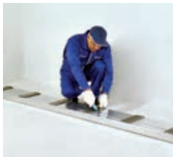
شکل ۸۲-۱- برش نوارهای عایق
