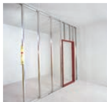
شکل ۱۳۹-۱- اجرای پانل دوم دور چهارچوب
