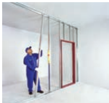
شکل ۱۳۴-۱- رانر تقویتی توسط پرچ به استاد متصل می شود.
