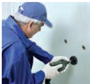
شکل ۱۰۲-۱- ایجاد خروجی تأسیسات به وسیله گرد بر
