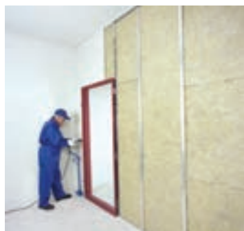
شکل ۱۴۰-۱- پانل گذاری در یک سمت دیوار تکمیل شده
