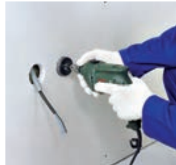
شکل ۱۷۳-۱ خروجی‌های تأسیساتی به وسیله گردبر ایجاد می‌شوند.
