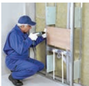
شکل ۱-۱۵۵- اتصال تراورس (تخته چند لایه) به قطعات نبشی L25
