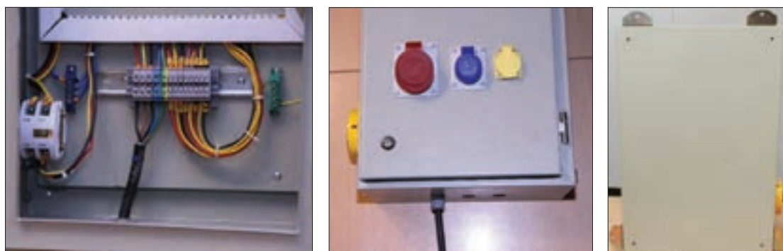
شکل ۵۷- نصب تابلو روی دیوار و تغذیه ورودی تابلو
