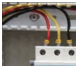
نصب درست شماره سیم
