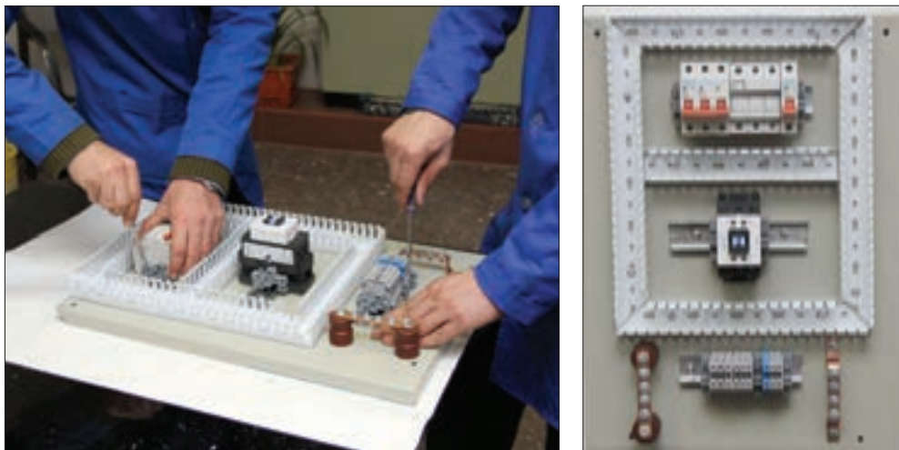
شکل ۸۴- نصب تجهیزات دیگر
