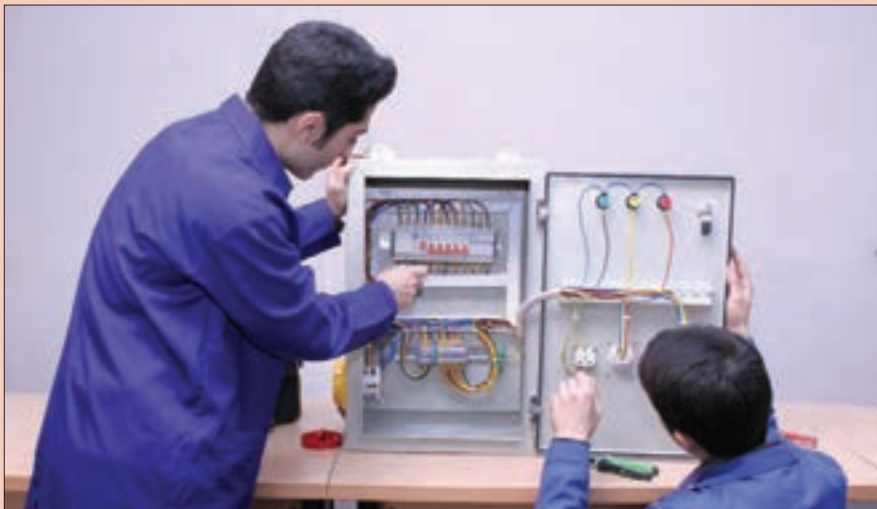
شکل ۳۰- قطعات الکتریکی و غیر الکتریکی تابلو برق
