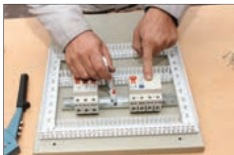
شکل ۴۲- محل نصب ریل فلزی
