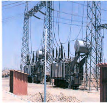
شکل (۲۸-۳) دو ترانسفورماتور موازی شده
