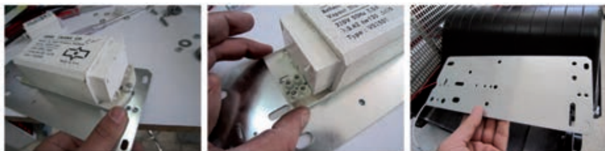
شکل ۲-۳۹ - نحوه نصب بالاست در نورافکن
