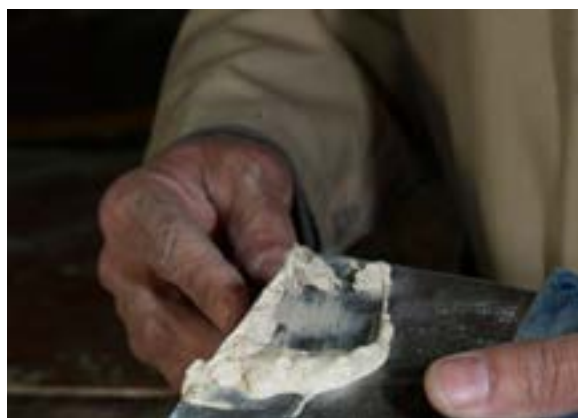
شکل ۱۵-۴. هر بار باید مقدار کمی بتونه روی لیسه قرار داد.
