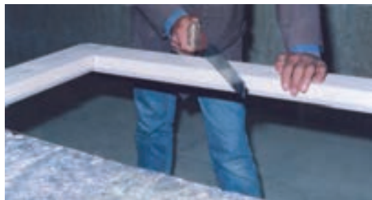
شکل ۱۱-۲۶- ایجاد شیار با اره‌ی دستی.
