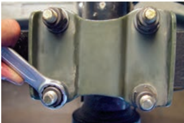
شکل ۳-۶۶- باز کردن مهره‌های کرپی‌ها (پیچ‌های U شکل)
