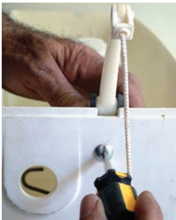
شکل ۳-۲۰۹- اتصال اهرم به بدنه‌ی مخزن فشاری
