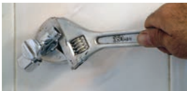
شکل ۳-۴۸ سفت کردن شیر پیسوار با آچار فرانسه
