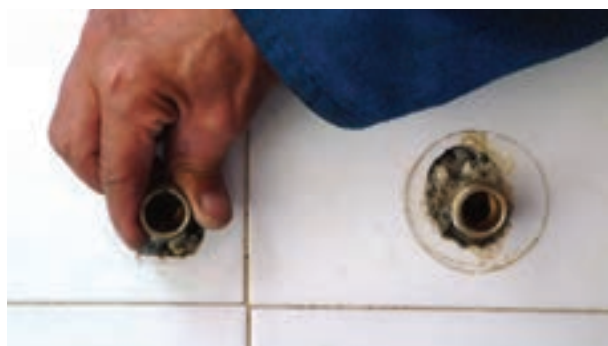
شکل ۱۸۴-۲- پیچیدن دنباله‌ها به محل نصب شیر
