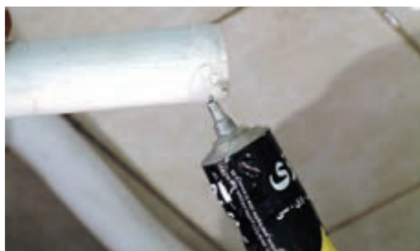
شکل ۳-۲۰۵- زدن چسب به لوله‌های تخلیه
