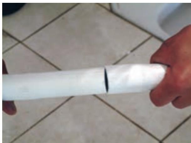
شکل ۳-۲۰۶- جا زدن لوله‌های تخلیه در درون یکدیگر
