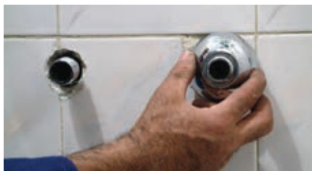
شکل ۲-۲۰۴- پیچیدن کاسه ها به دنباله ها
