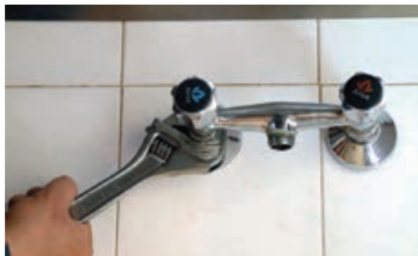
شکل ۲-۱۸۹- سفت کردن مهره ها با آچار فرانسه
