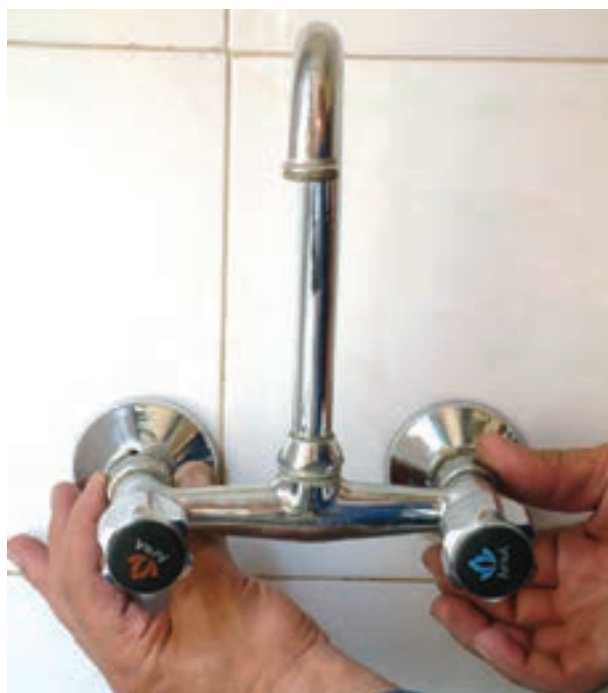
شکل ۱۷۲-۲ پیچیدن مهره‌ها به دنباله‌های شیر مخلوط
