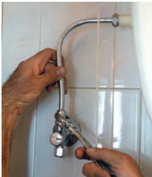
شکل ۳-۲۲۳- اتصال لوله‌ی پیسوار به شیر شناور و شیر پیسوار
