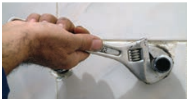
شکل ۱۶۷-۲ سفت کردن دنباله‌ها با آچارفرانسه
