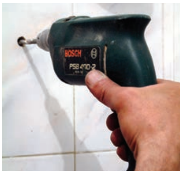
شکل ۳-۴۱ سوراخ کاری محل نصب پیچ ها
