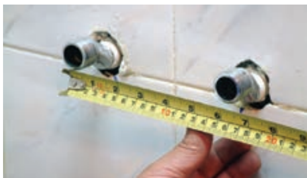
شکل ۱۶۸-۲ کنترل اندازه‌ی محور تا محور دنباله‌ها
