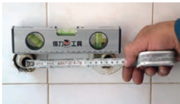
شکل ۲-۱۸۶- کنترل صاف بودن و اندازه‌ی دنباله‌ها
