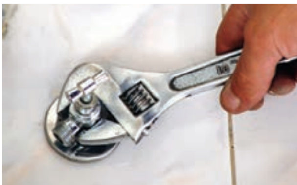
شکل ۲۲۰-۳- سفت کردن شیر پیسوار با آچار فرانسه
