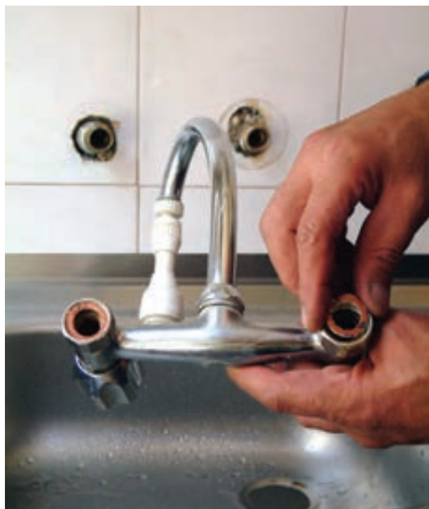
شکل ۱۷۱-۲- قراردادن واشر درون مهره‌ی تنه شیرمخلوط
