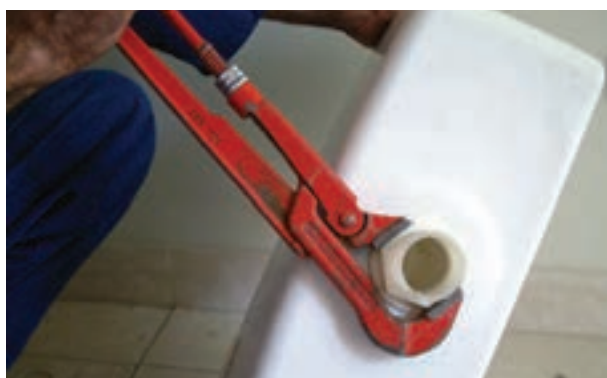
شکل ۳-۲۰۸- سفت کردن مهره‌ی پمپ تخلیه
