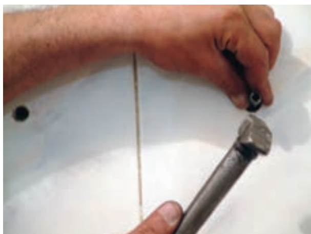
شکل ۳-۴۲ کوبیدن رولپلاک ها در درون سوراخ ها
