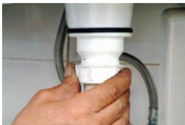
شکل ۳-۵۶ بستن مهره‌ی لوله‌ی عمودی سیفون به زیراب
