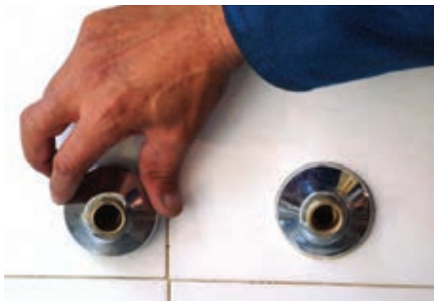
شکل ۱۷۰-۲- بستن کاسه‌ها به دنباله‌ها با دست
