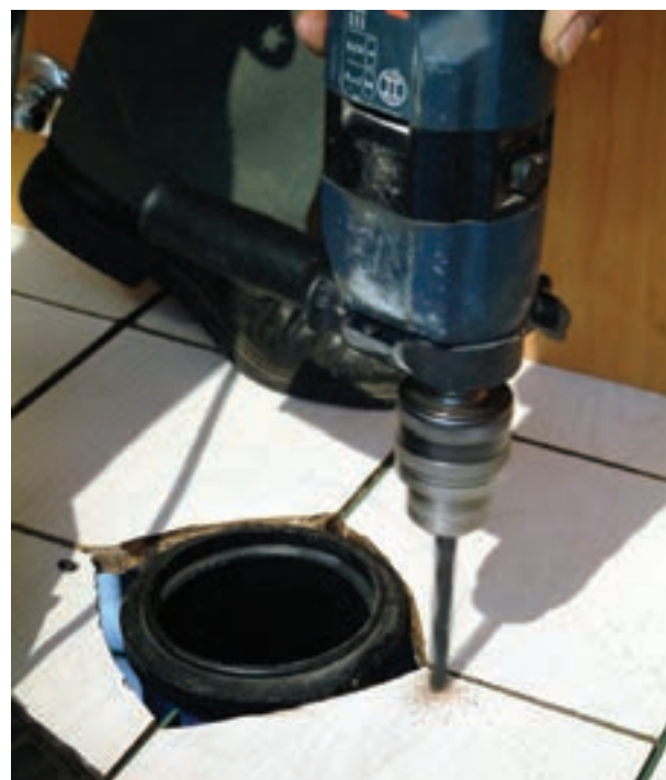
شکل ۲۴۶-۳- سوراخ‌کاری محل‌های علامت‌گذاری شده
