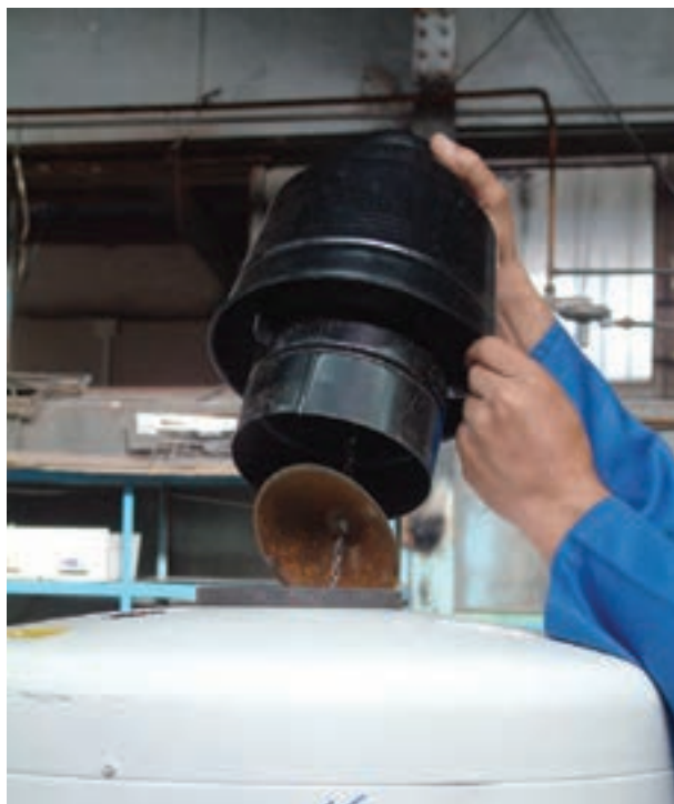
شکل ۱۱۵-۱ برداشتن کلاهک تعدیل از روی دودکش
