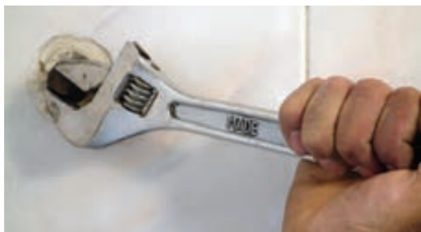
شکل ۱۹۸-۲- باز کردن درپوش‌ها
