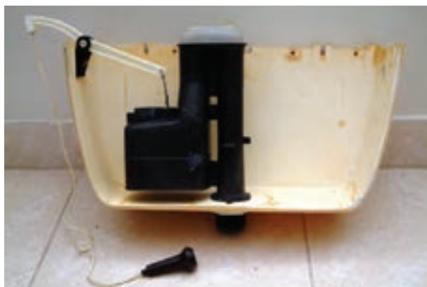
شکل ۳-۲۰۷- نصب پمپ تخلیه درون مخزن فشار
