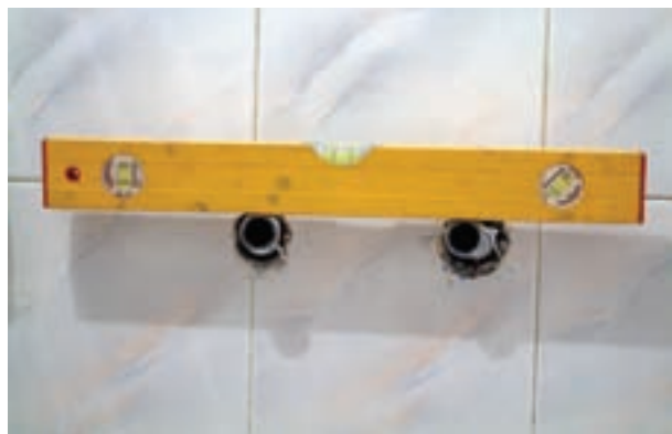
شکل ۱۶۹-۲- کنترل صاف بودن دنباله‌ها
