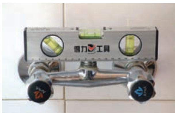
شکل ۱۷۴-۲ سنجش تراز بودن شیر مخلوط دیواری
