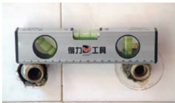
شکل ۲-۲۰۳- کنترل تراز بودن دنباله ها
