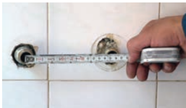
شکل ۲-۲۰۲- کنترل نمودن فاصله ی دنباله ها به وسیله ی متر
