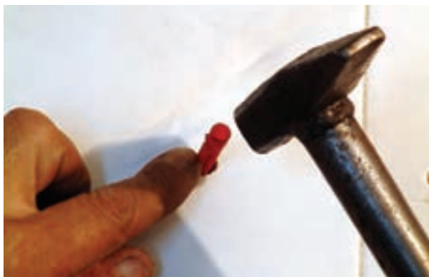
شکل ۱۹۳-۲- کوبیدن رولپلاک درون سوراخ
