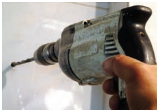
شکل ۲-۱۹۲- سوراخ کردن محل نصب بست آویز
