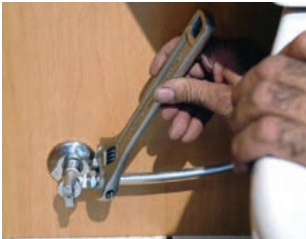
شکل ۳-۲۵۶- سفت کردن مهره‌ی شیر پیسوار
