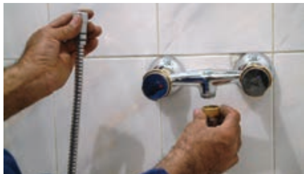
شکل ۲-۱۹۱- اتصال شیلنگ آفتابه به شیر مخلوط توالت
