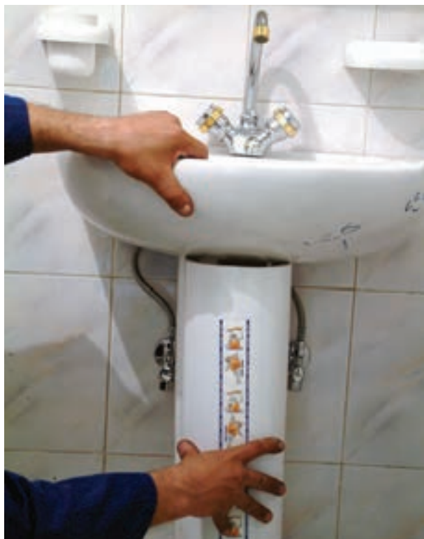
شکل ۳-۵۸- قرار دادن پایه‌ی دست‌شویی در زیر آن
