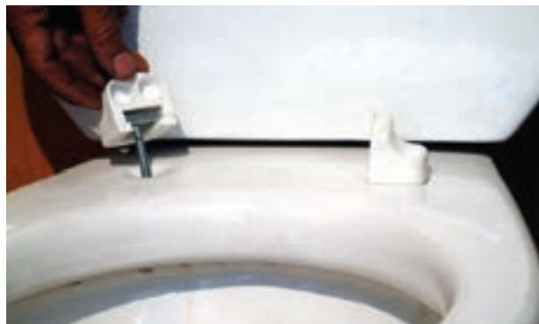
شکل ۲۵۳-۳ اتصال بست‌های نگهدارنده به توالت فرنگی
