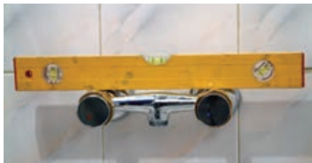
شکل ۲-۱۹۰- سنجش تراز بودن شیر مخلوط
