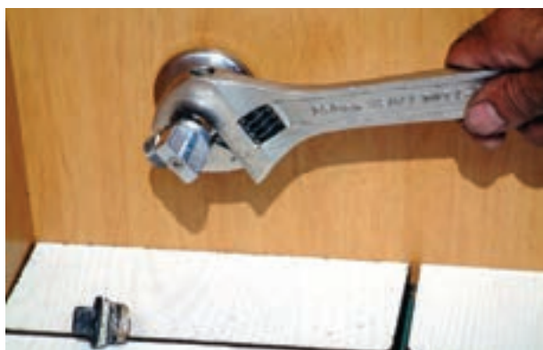
شکل ۲۵۴-۳ سفت کردن شیر پیسوار
