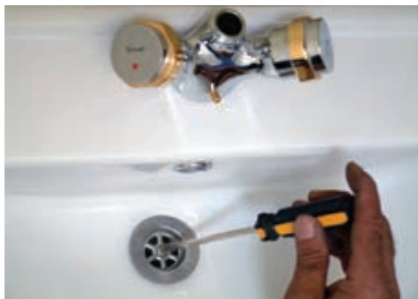
شکل ۳-۴۰ نصب زیراب بر روی دستشویی
