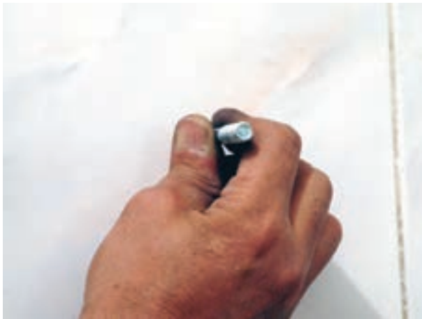
شکل ۳-۴۳- بستن پیچ‌ها در درون رولپلاک‌ها با دست
