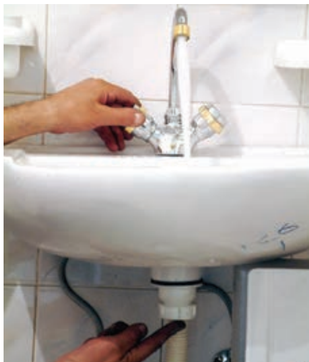
شکل ۳-۵۷ عمل کنترل نشت آب از محل‌های اتصال
