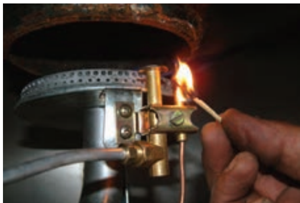
شکل ۱-۱۰۵ مشتعل کردن شمعک به وسیله‌ی شعله‌ی کبریت
