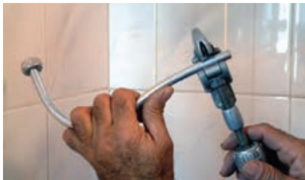
شکل ۳-۲۲۲- بریدن لوله‌ی پیسوار به وسیله‌ی لوله‌بر
