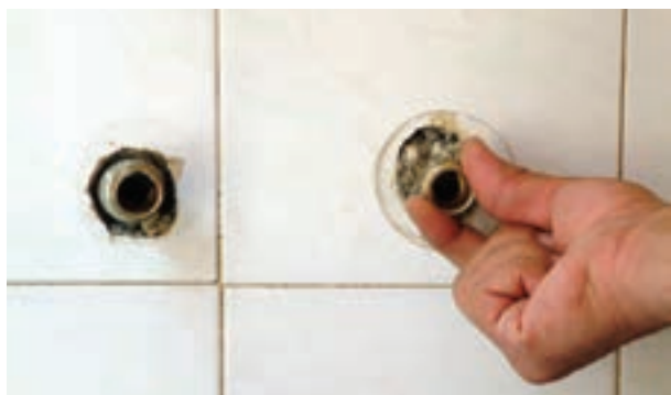
شکل ۲۰۰-۲- بستن دنباله‌ها با دست
