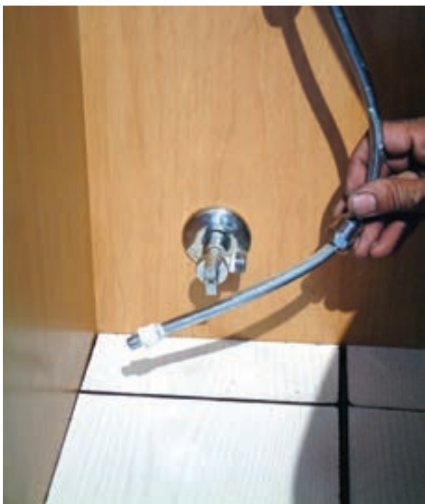
شکل ۲۵۵-۳ خمکاری لوله‌ی پیسوار
