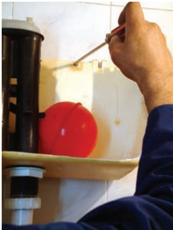
شکل ۲۱۳-۳ نصب مخزن فشاری به دیوار
