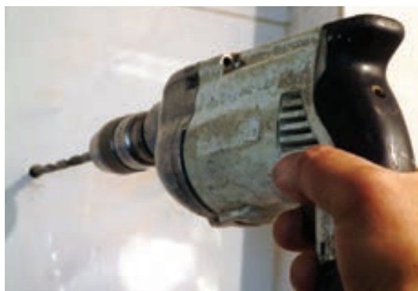
شکل ۲-۱۹۲- سوراخ کردن محل نصب بست آویز
