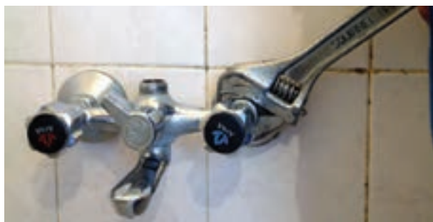
شکل ۲-۲۰۶- سفت کردن مهره‌های شیر با آچار
