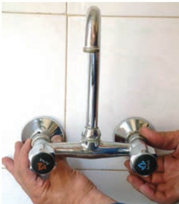
شکل ۱۷۲-۲ پیچیدن مهره‌ها به دنباله‌های شیر مخلوط
