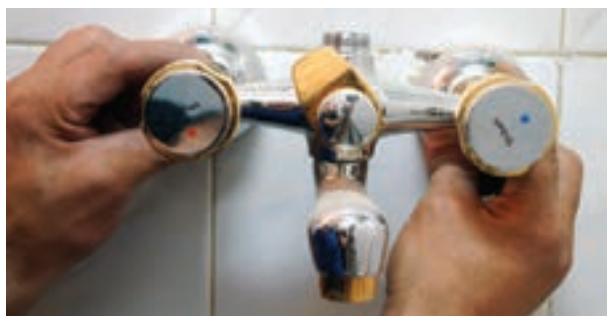
شکل ۲-۲۰۵- بستن مهره‌های شیر مخلوط دوش با دست
