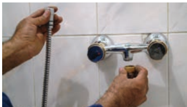
شکل ۲-۱۹۱- اتصال شیلنگ آفتابه به شیر مخلوط توالت
