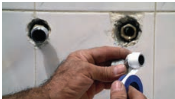
شکل ۱۸۳-۲- پیچیدن نوار تفلون به دنباله‌ها
