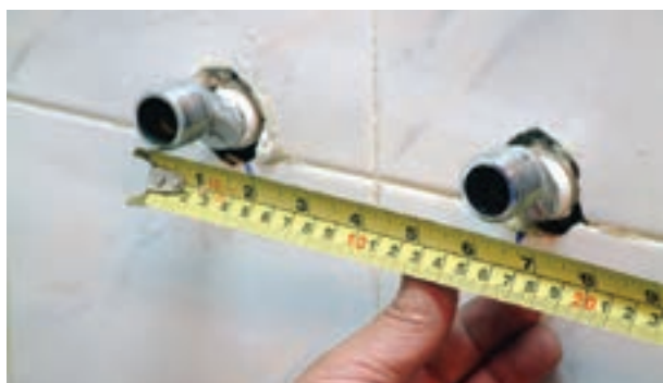
شکل ۲-۱۶۸- کنترل اندازه‌ی محور تا محور دنباله‌ها
