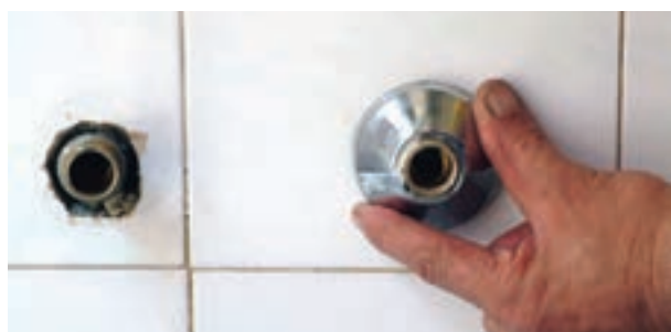
شکل ۲-۱۸۷- اتصال کاسه‌ها به دنباله‌ها
