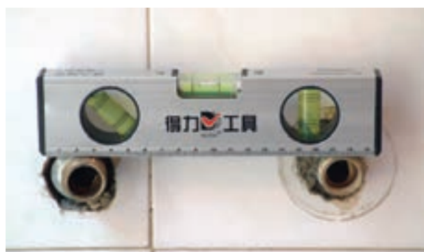
شکل ۲-۲۰۳- کنترل تراز بودن دنباله‌ها
