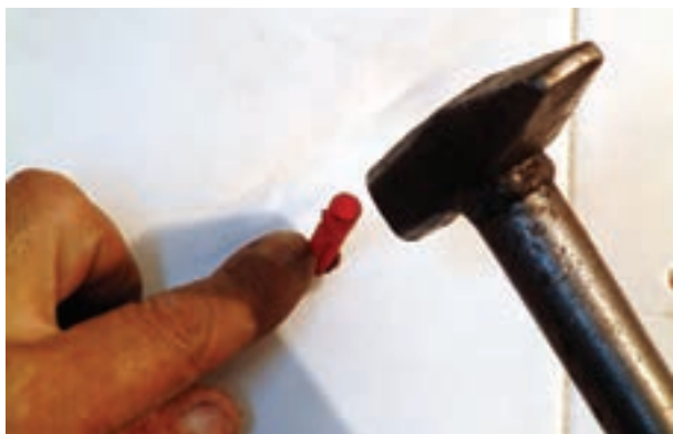
شکل ۱۹۳-۲- کوبیدن رولپلاک درون سوراخ
