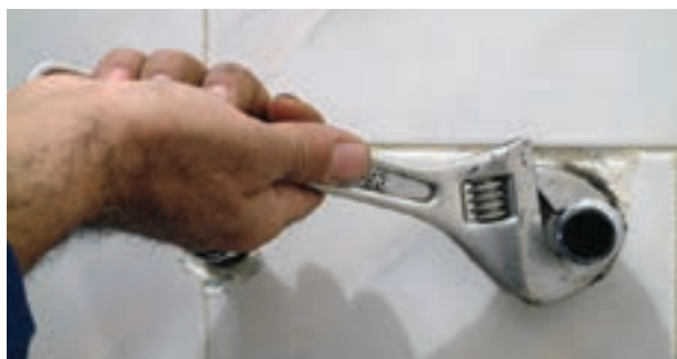
شکل ۲-۱۶۷- سفت کردن دنباله‌ها با آچارفرانسه
