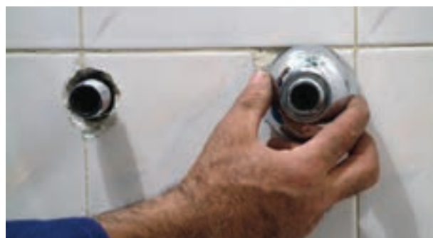
شکل ۲-۲۰۴- پیچیدن کاسه‌ها به دنباله‌ها
