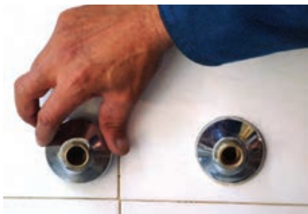
شکل ۱۷۰-۲- بستن کاسه‌ها به دنباله‌ها با دست
