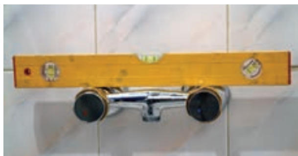
شکل ۲-۱۹۰- سنجش تراز بودن شیر مخلوط
