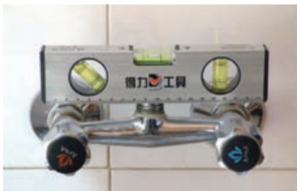
شکل ۱۷۴-۲ سنجش تراز بودن شیر مخلوط دیواری
