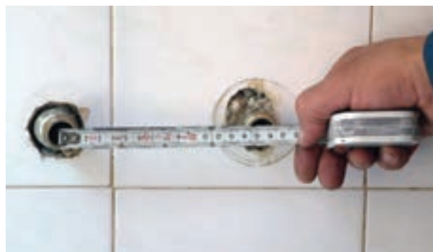
شکل ۲-۲۰۲- کنترل نمودن فاصله‌ی دنباله‌ها به وسیله‌ی متر
