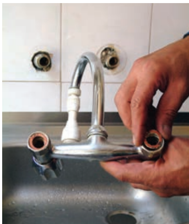
شکل ۱۷۱-۲- قراردادن واشر درون مهره‌ی تنه شیر مخلوط
