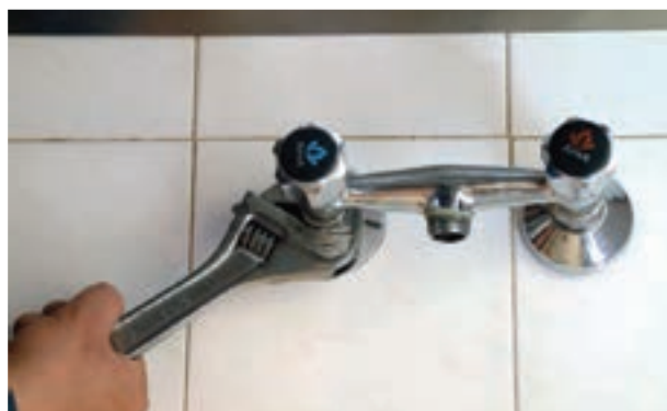
شکل ۲-۱۸۹- سفت کردن مهره ها با آچار فرانسه
