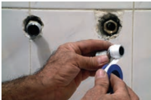
شکل ۲-۱۶۵- پیچیدن نوار تفلون به دنده‌ی \frac{1}{4} دنباله‌ی شیر
