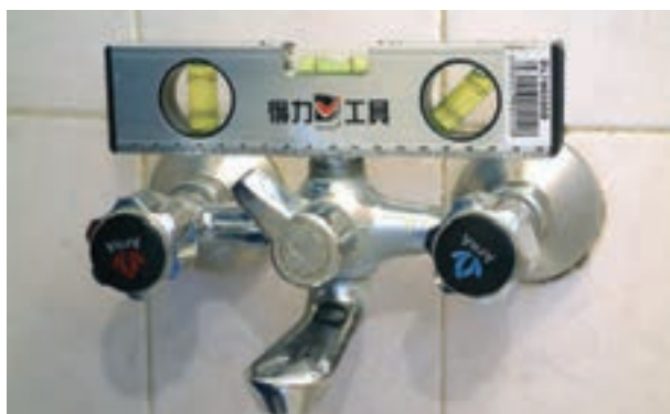
شکل ۲-۲۰۷- سنجش تراز بودن شیر مخلوط دوش
