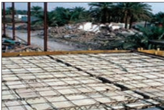
شکل ۱۳-۱ سقف تیرچه بلوک
