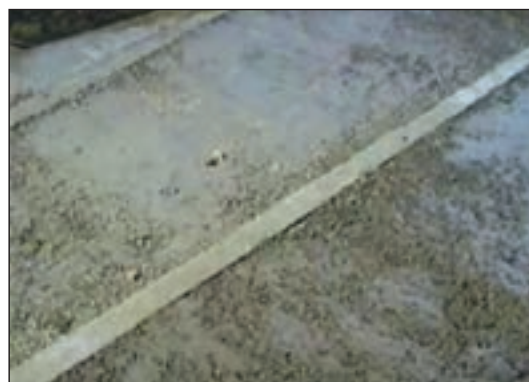
شکل ۲۱-۶ پرکردن فضای بین کرم‌ها با پوکمه معدنی
