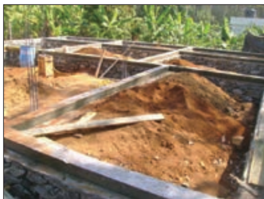
شکل ۲۰۵-۱ بتن ریزی کلاف بندی افقی تحتانی
