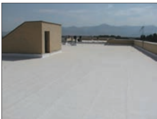
شکل ۱۲-۶ سطح پشت بام
