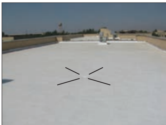
شکل ۱۱-۶ سطح پشت بام
