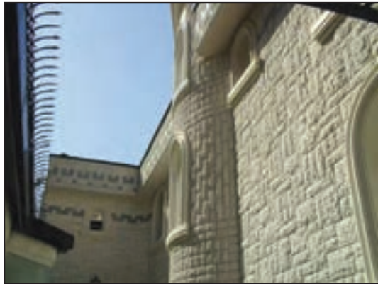
شکل ۱۳۱-۱ دیوار با مصالح سنگ بادبُر
