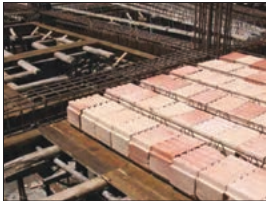
شکل ۱-۱۵۲ کاربرد بلوک سفالی در سقف
