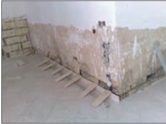
شکل ۹۰-۱ اندود گچ و خاک - گچ سفید پرداختی
