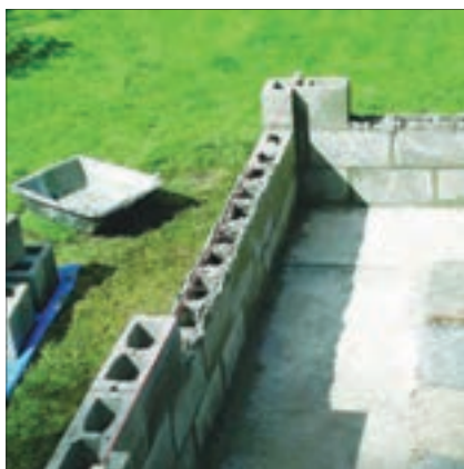
شکل ۱۵۰-۱ ساخت دیوار با بلوک‌های بتنی یا سیمانی
