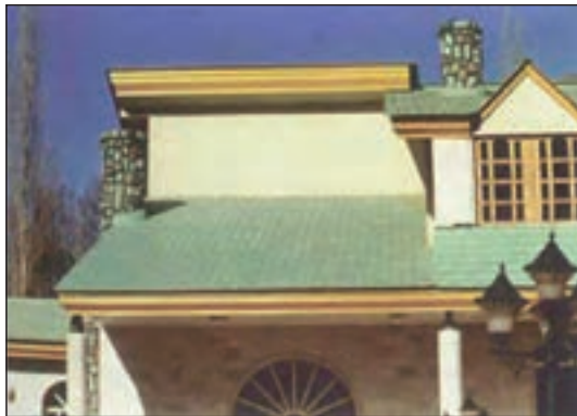
شکل ۱-۱۰۲ پوشش سقف با ورق‌های فشرده‌ی آردواز
