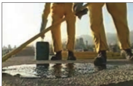
شکل ۲۲-۶ قیرگونی پس از پرکردن بین کُرْم‌ها
