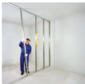
نصب استاد بر روی ساختار جانبی اتصال استاد به دیوار بنایی با رول پلاک
