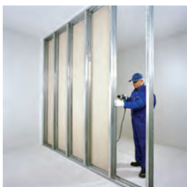
اجرای پانل‌ها در یک طرف دیوار
