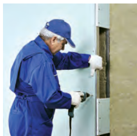
اجرای پانل ها در طرف دیگر دیوار
