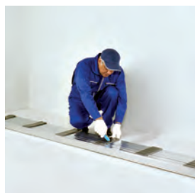
برش نوارهای عایق
