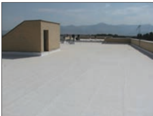
شکل ۱۲-۶ سطح پشت بام
