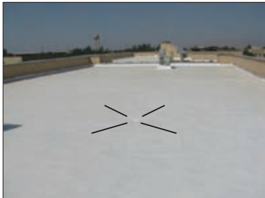
شکل ۱۱-۶ سطح پشت بام
