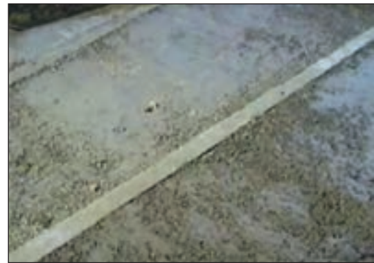
شکل ۲۱-۶ پرکردن فضای بین کرم‌ها با پوکمه معدنی
