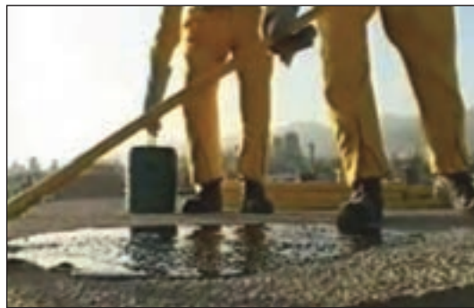
شکل ۲۲-۶ قیرگونی پس از پرکردن بین کُرْم‌ها
