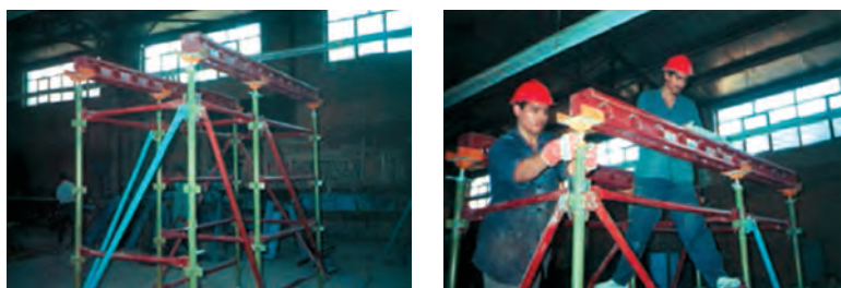
شکل ۵-۷- استقرار داربست زیر سقف
