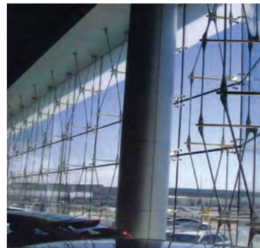
نمونه‌هایی از نمای شیشه‌ای عنکبوتی با روش سازه کابلی ساده و خرپایی
