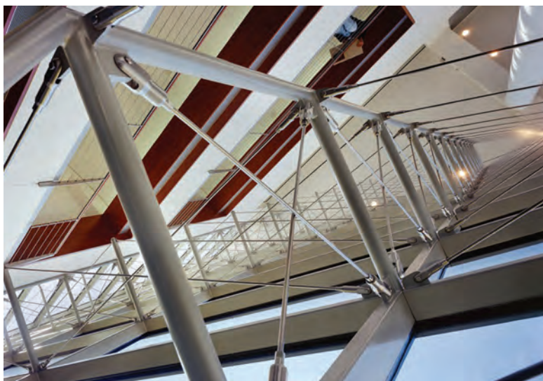
نمونه‌هایی از نمای شیشه‌ای اسپاندری با سازه خرابایی فلزی
