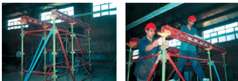
شکل ۵-۷- استقرار داربست زیر سقف
