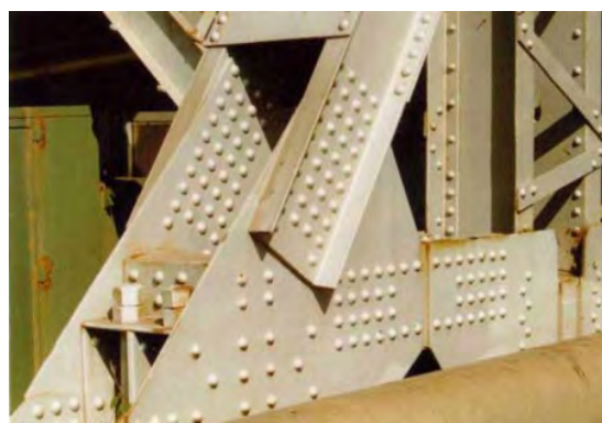
شکل ۳-۱۸ (الف) سازه فلزی اتصال پرچی
