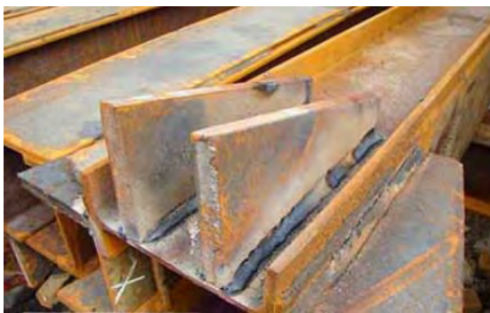
ب) شکل ۳-۱۹ اتصال سازه فلزی جوش کاری
